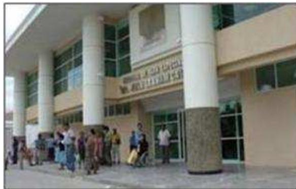
Instalaciones del H.R.A.E. “Dr. Juan Graham Casasús”, 2012.
